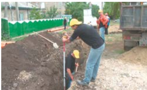
Construcția apeductului și canalizării
