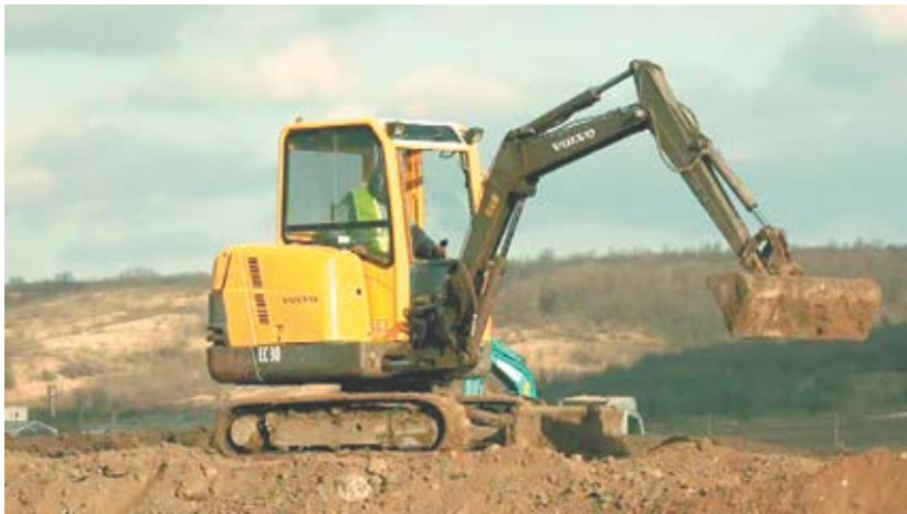
Excavarea terenului pentru stația de epurare Ecaterinovca
